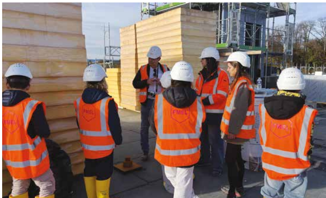
La FMEL a participé à la JOM en accueillant deux écoliers : ici, visite du chantier des futurs logements étudiants sur le Campus Santé, aux côtés d'un autre groupe d'enfants, accompagnés par l'architecte de la FMEL, Pierre Menoux.
