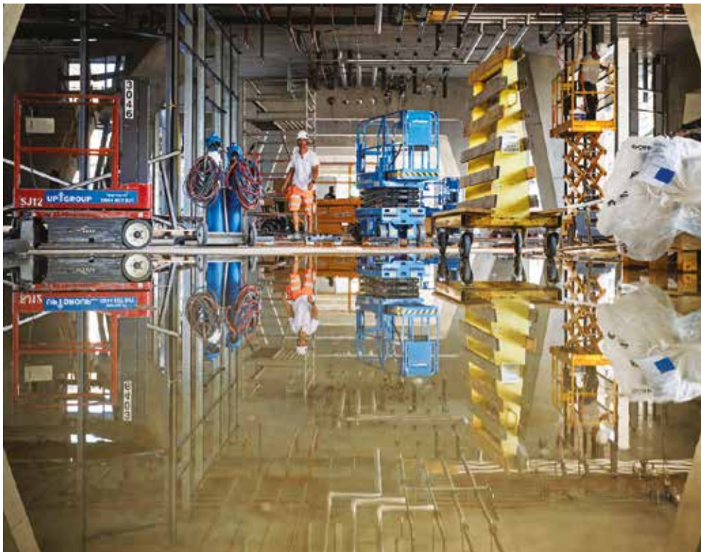
Le chantier du futur LET – Campus Santé avance : son reflet esquisse déjà les contours de l'avenir de la FMEL.
