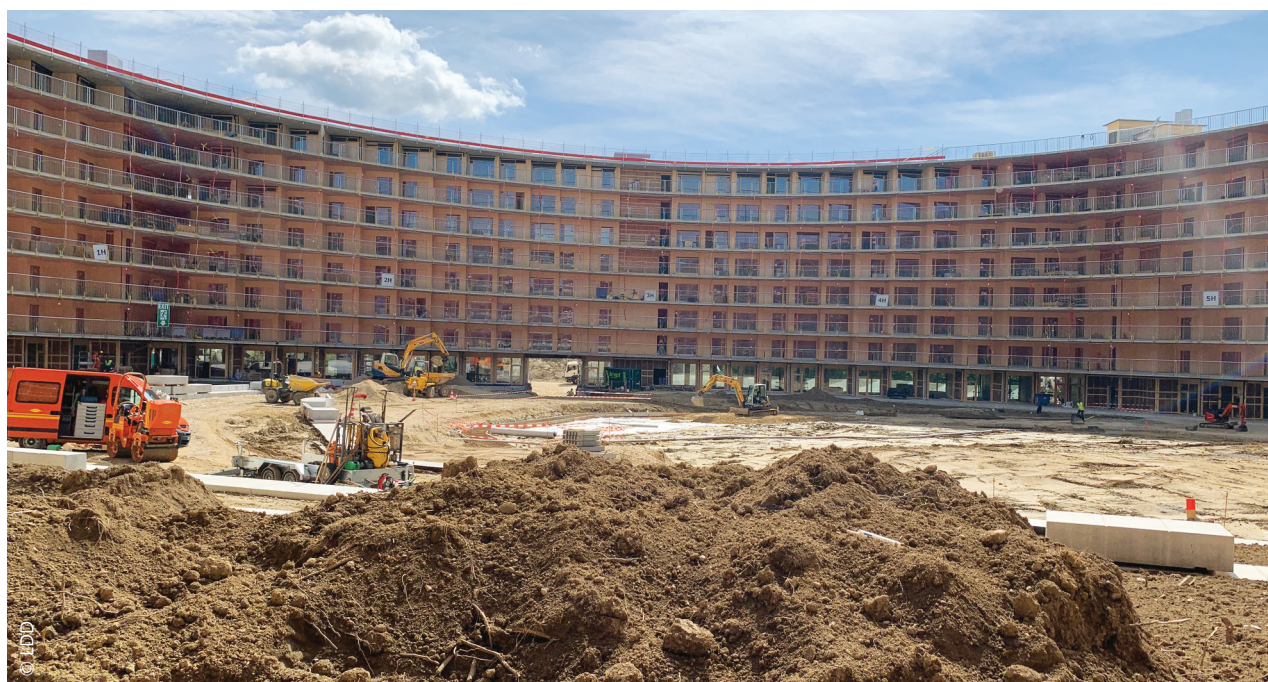
Visite du chantier du Vortex en mai 2019.
